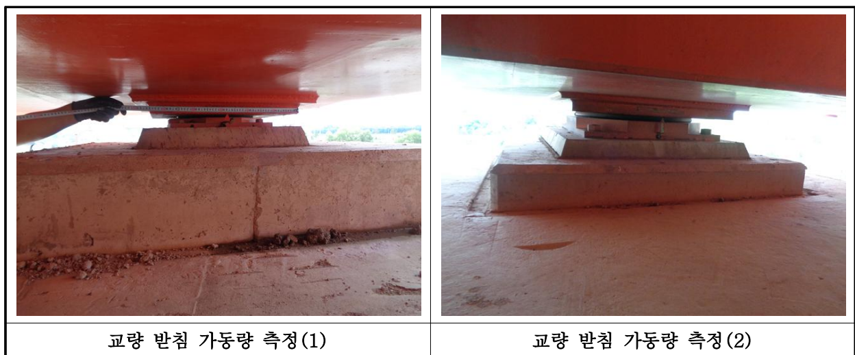
【사진 1.3.15】 교량받침 이동량 측정
