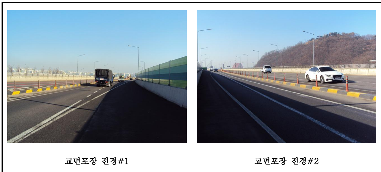
【사진 1.3.19】 교면포장 전경
