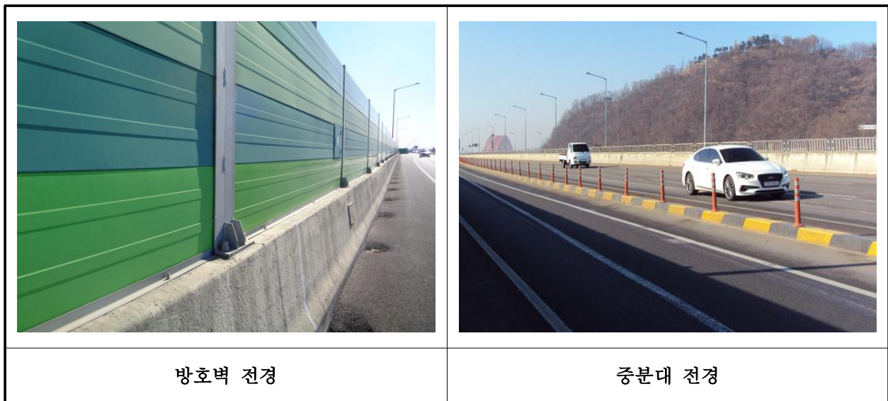
【사진 1.3.23】 방호벽 및 중앙분리대 전경
