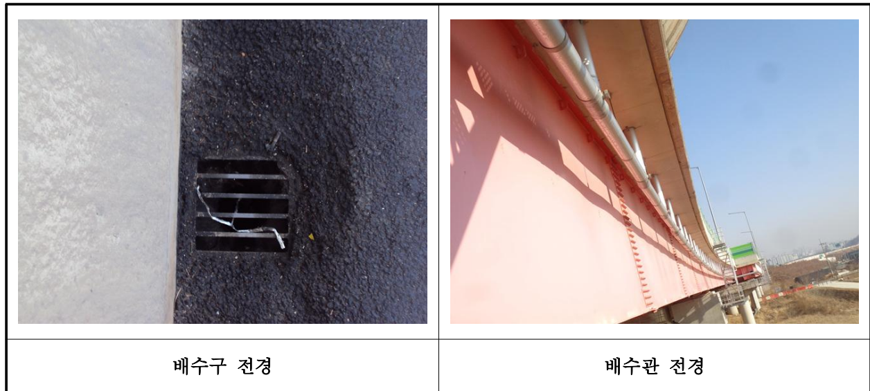
【사진 1.3.21】 배수시설 전경
