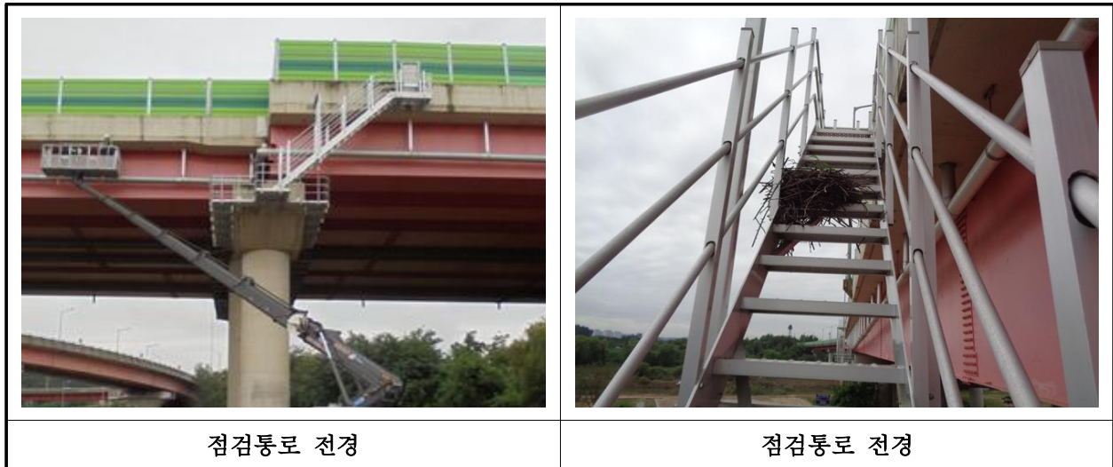
【사진 1.3.25】 교량 점검시설 전경
