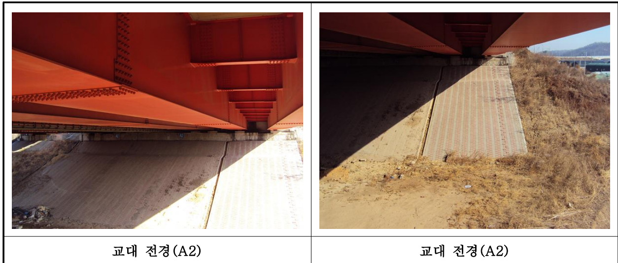
【사진 1.3.8】 교대 전경
