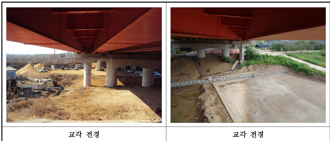
【사진 1.3.10】 교각 전경
