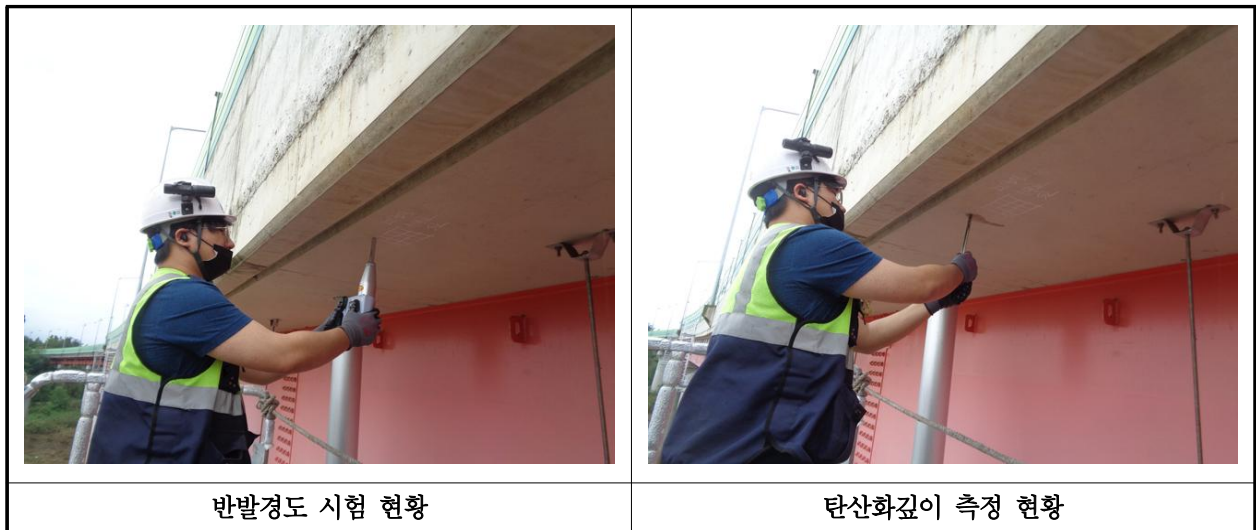
【사진 1.4.1】 콘크리트 내구성조사 현황
